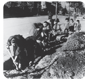
⑱ 防空壕掘り（松降通1丁目） 昭和18年（1943）
